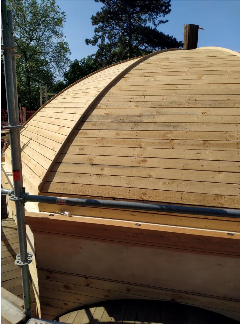
Schrijnwerk koepel en goten
